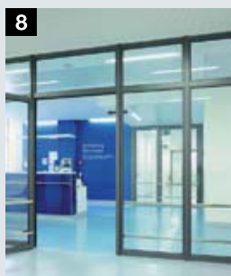
8 Protipožiarne a dymotesné prvky rúrkového rámu
