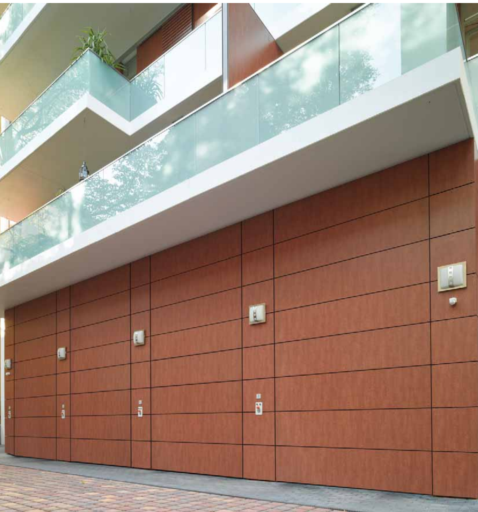
Obloženie zo strany stavebníka s vrstvenými lisovanými drevenými platňami
